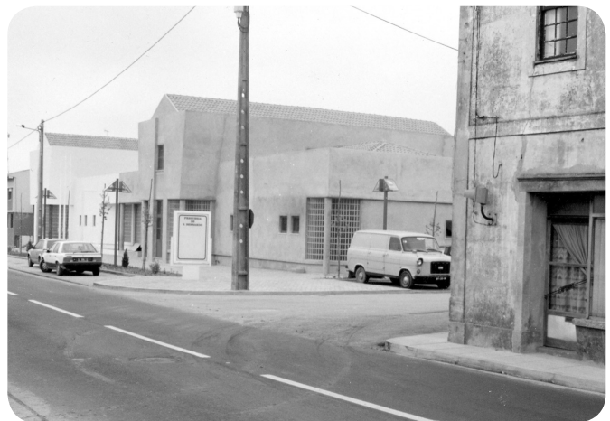
Antiga Junta de Freguesia e finalização da nova sede, na Rua Cónego Maio.
